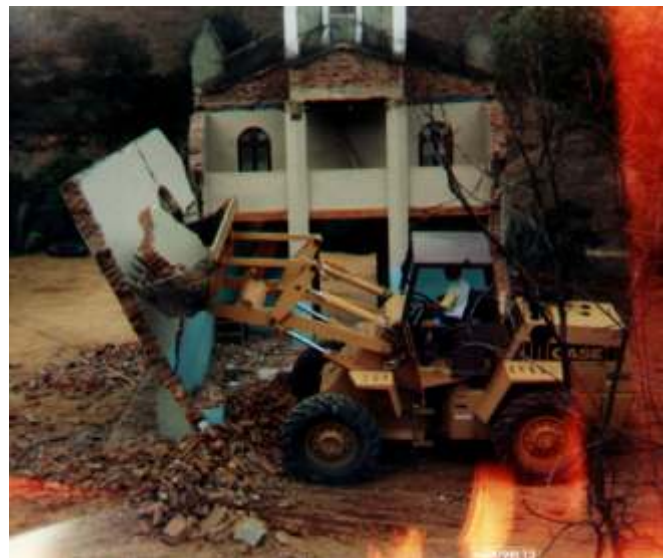
Impiedosa, a máquina de ferro não sente que está interrompendo a história da Capela, dos sentimentos da comunidade.
