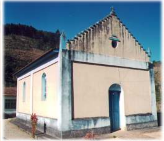
Foto realizada em nossa visita de 10/08/2000. Recebeu reforma em 11/05/78.
