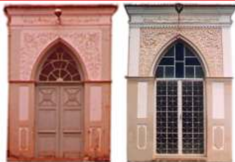
Duas épocas da porta da Capela: em madeira e em ferro.
