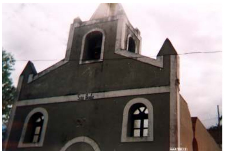
Em março de 1998, a demolição dessa construção (vista na foto da esquerda).
